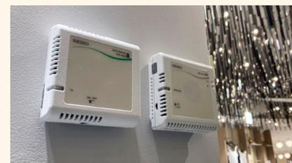
(左)環境測定センサーCO<sub>2</sub>センサー (右)室温センサー
